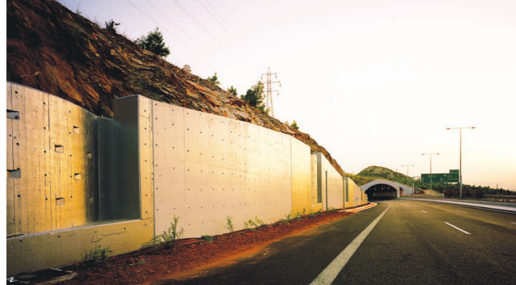
Εικ. 2 Τοιχείο αντιστήριξης σε διάλογο με τον βράχο και το μεταβαλλόμενο φως (Φωτογράφος Εριέτα Απάλη).
