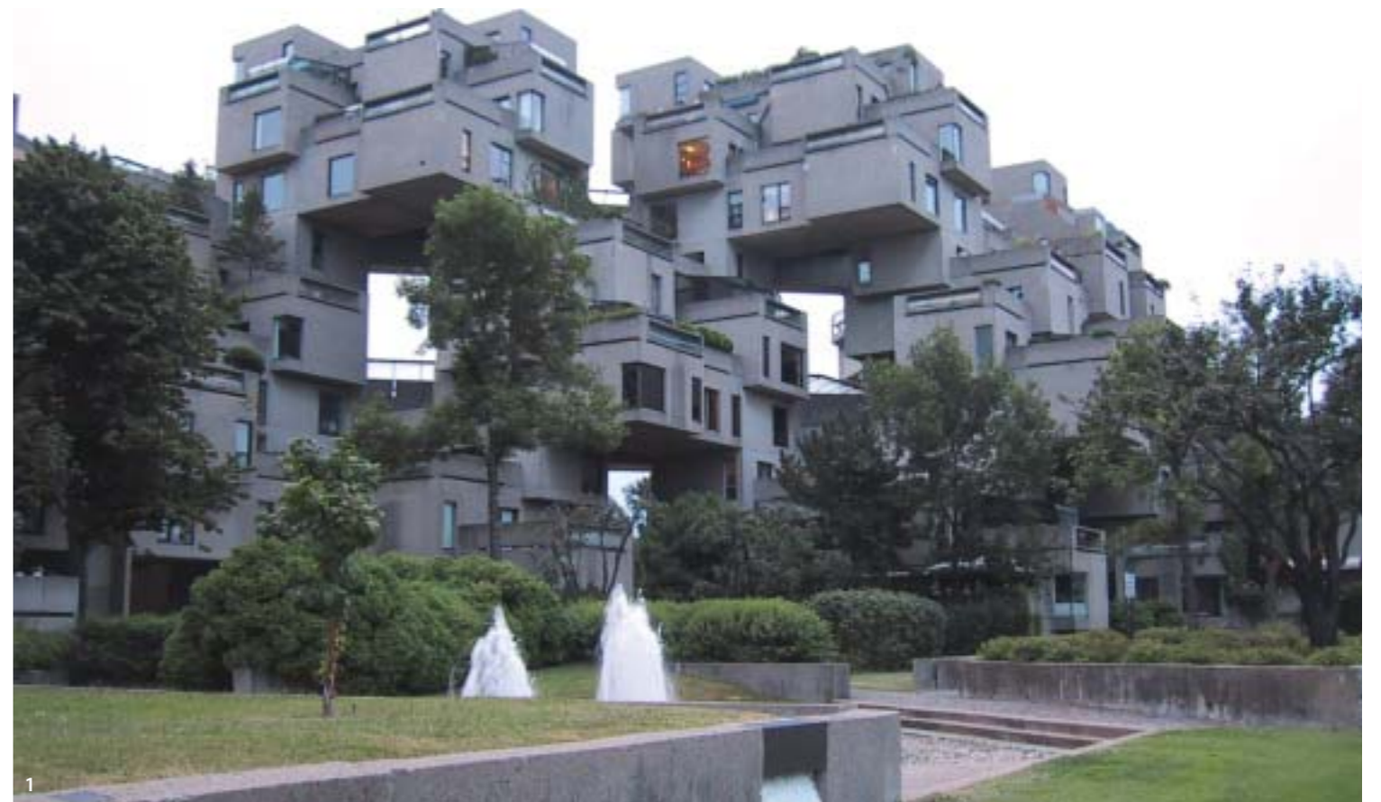
Εικ.1. Η αρχική πρόθεση ήταν να δημιουργηθεί ένα ευέλικτο σύστημα εργατικών κατοικιών που θα παρέχει ποιότητα κατοίκησης.
