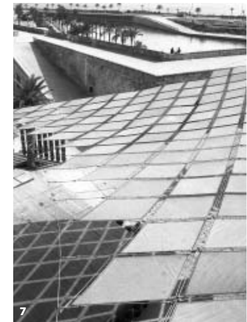
Εικ. 7. Τα διάκενα της τέντας επιτρέπουν στον αέρα να περνά ελεύθερα και να μην καταστρέφει το ύφασμα και τη δομή.
